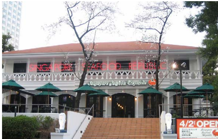
写真:建物の外観
