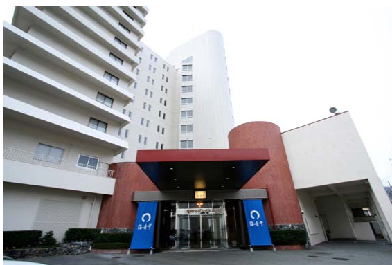
エントランス付近
